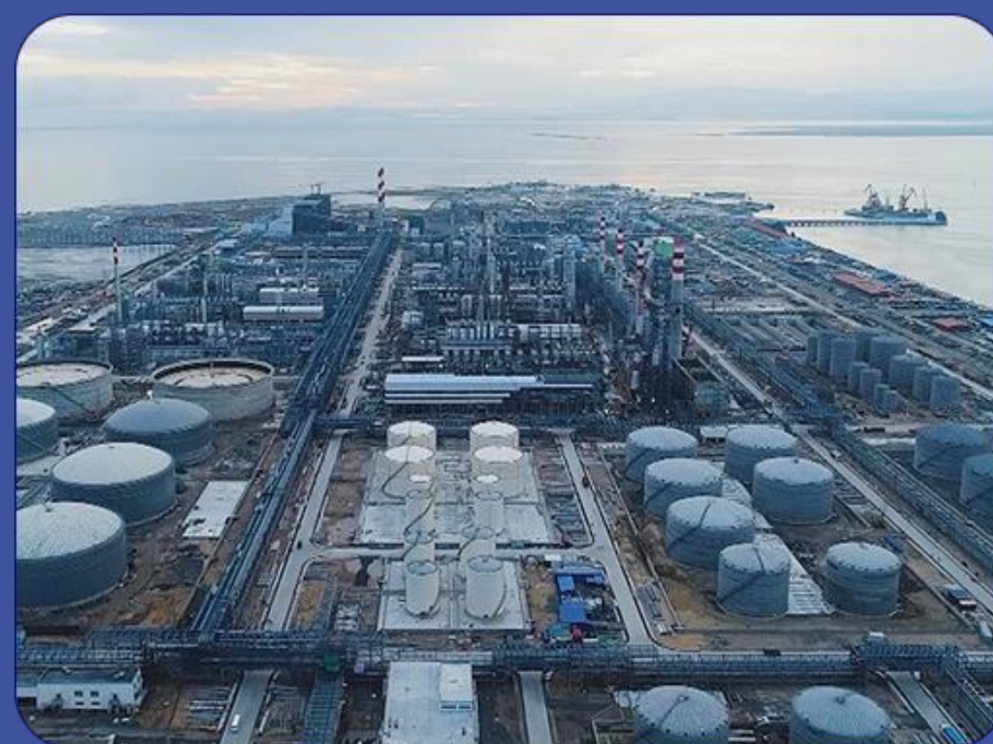
Газоперерабатывающий комплекс (СПГ) в Усть-Луге Строительство портовой зоны погрузки ТГ: клеммы DIN, реле
